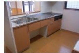
車いすでも使い物ができるシステムキッチンを設置
