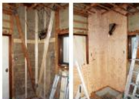
▲ すじかい補強 ▲ 構造用合板補強
